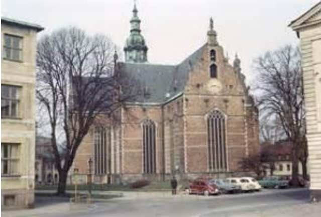
Schwedische Kirche: Im Bereicherungszustand
