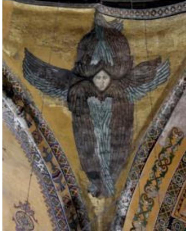
Dieser Seraph erschien, nachdem schadhafter Putz entfernt wurde.
