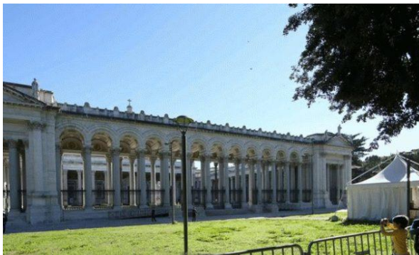
Das Erdbeben vom 30. Oktober richtete auch in Rom Schäden an, so an der päpstlichen Basilika San Paolo fuori le Mura
